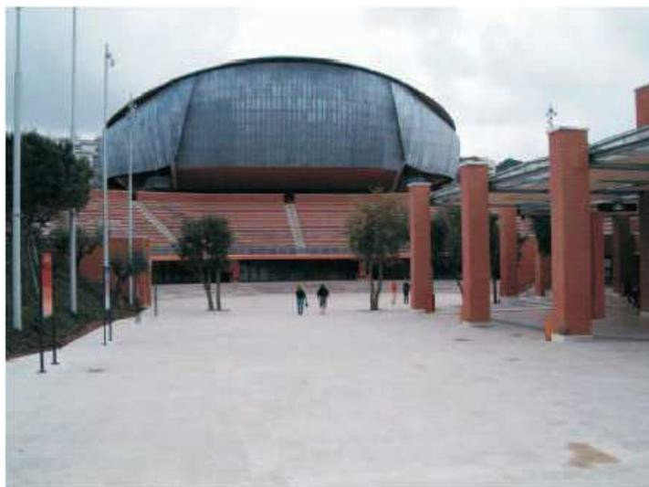
Figura 3.3: Vista dell'esterno del complesso, con in evidenza la copertura in piombo della sala.
